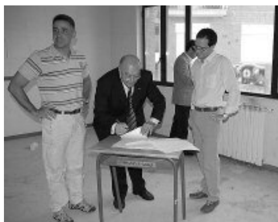
Il dott. Lupo dà il via ai lavori di ristrutturazione (foto Sciurba)
